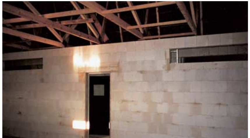
Auflagerung der Binder auf der Trennwand
