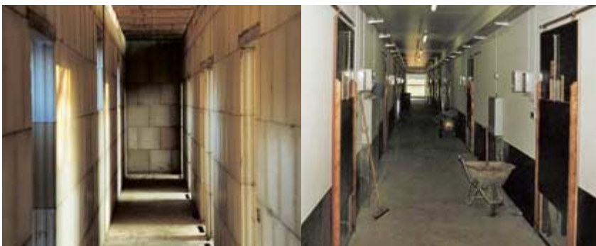
Zentralgang Schweinestall – im Rohbau
