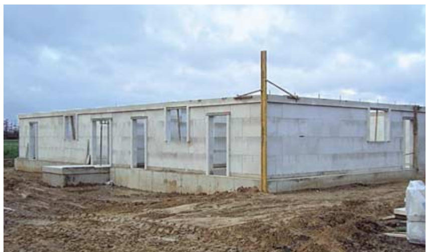
Rohbau eines Schweinestalls in zweischaliger Bauweise
